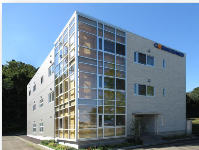
本社社屋 木造3階建 CLTパネル工法 県産スギ材使用 2018年8月竣工
